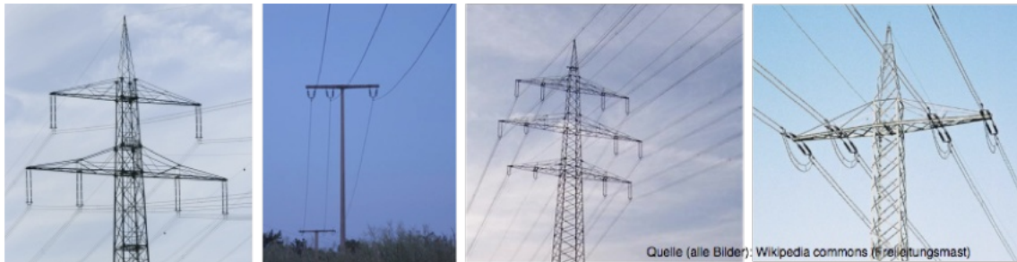
Abbildung 1.4.3 Systeme auf Freileitungen
